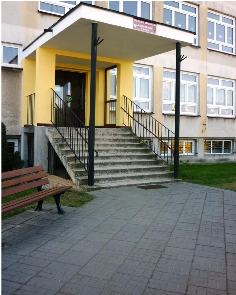
Przedszkole Samorządowe w Osiecznej – wejście główne
